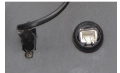
Strom- und LAN Anschluss Box-Unterseite
